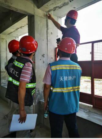
图9 前海局组织装配式建筑专家现场检验
