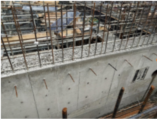
图8 施工缝凿毛结果
