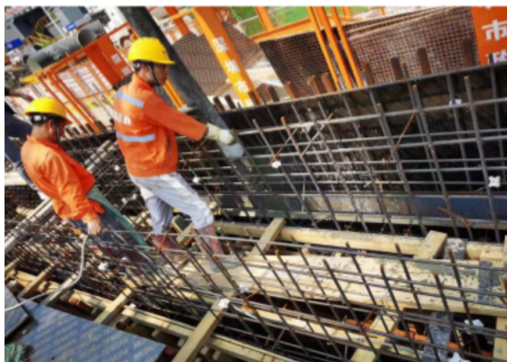
图1 控制下料点高度
