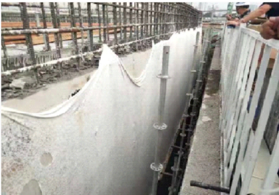
图6 池壁两侧覆盖土工布
