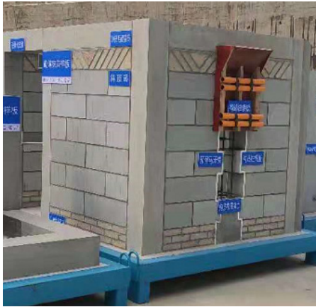
图4 砌筑施工工艺样板
