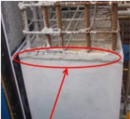
图9 施工缝涂抹水泥砂浆
