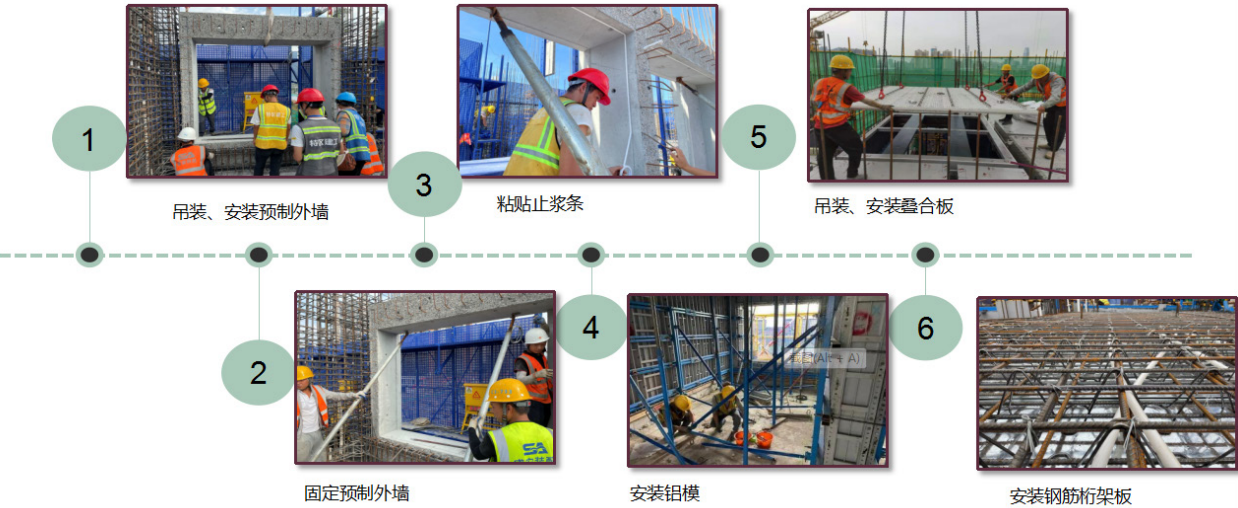
图8 装配式构件施工流程
