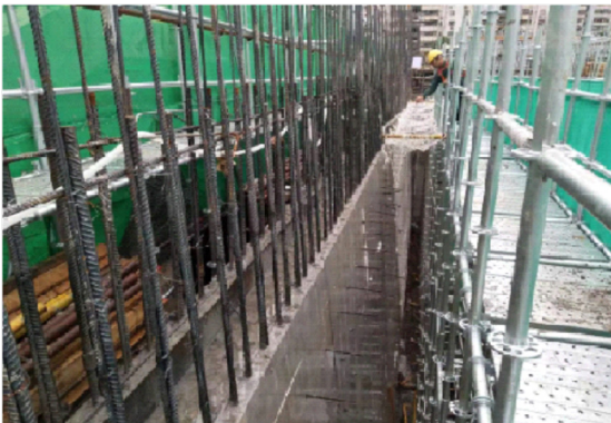
图7 池壁两侧浇水养护
