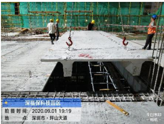
图9 双T板现场吊装
