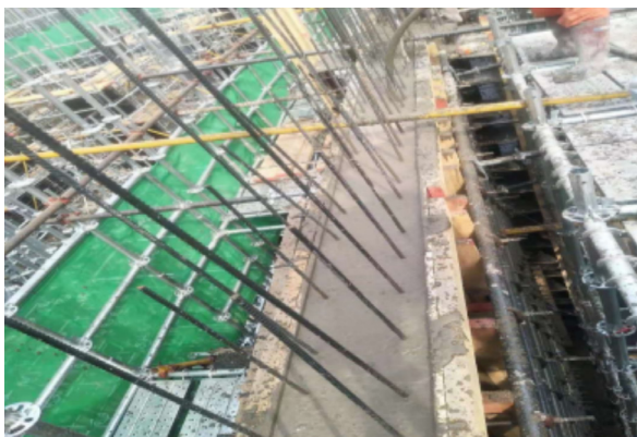
图4 墙体混凝土抹平
