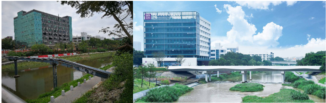
图6 老旧工业园区变身为中科院深圳理工大学过渡校区
