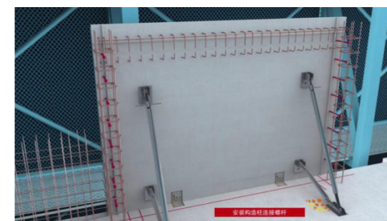
(g) 安装构造柱连接螺栓
