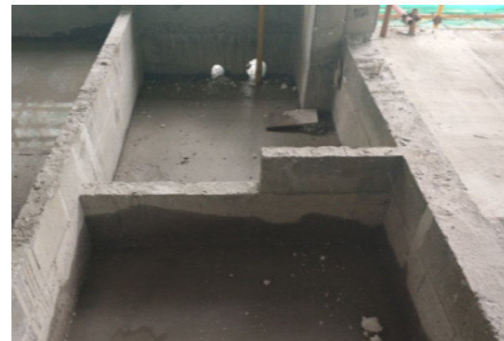
图1 卫生间内隔墙反坎未考虑沉箱管道
