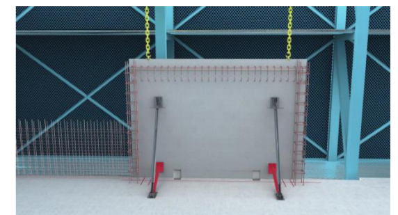
(f) 安装临时斜支撑
