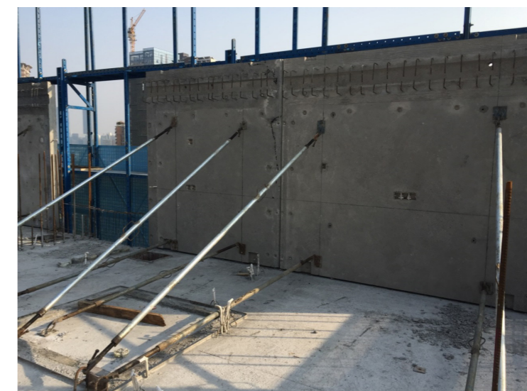
图10 预制外墙安装现场
