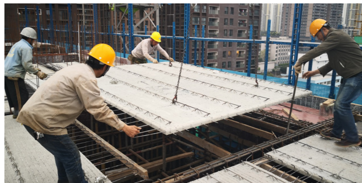
图12 叠合楼板吊装现场
