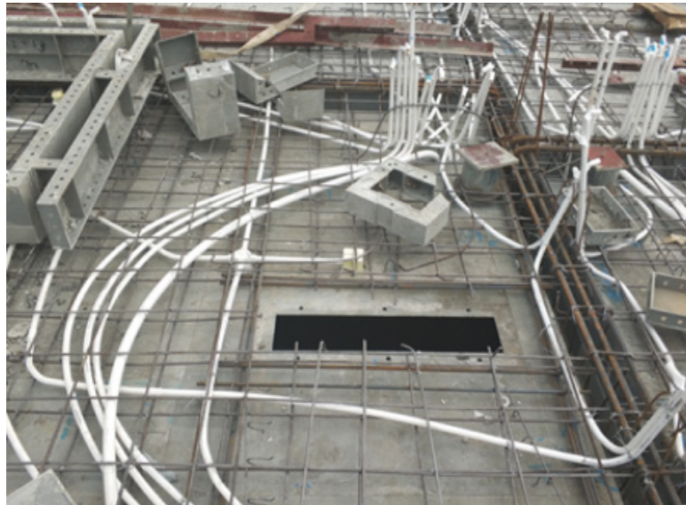
图2 管线绕弯避开传料口
