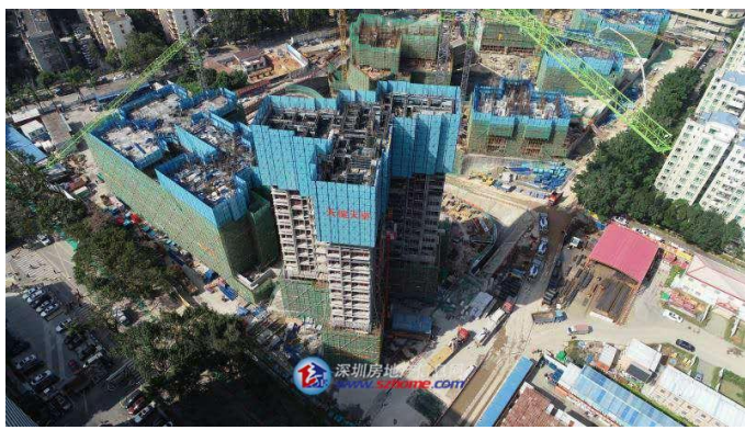
图表28: 天骄项目现场施工图
