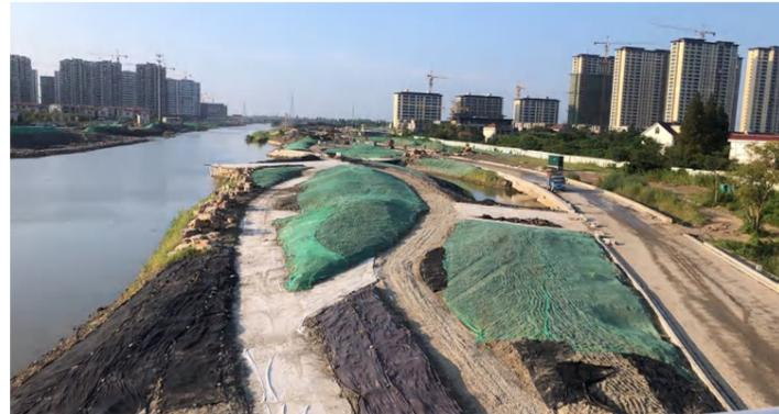
不间断运转，密闭运输的渣土车驶过车辆自动冲洗池，现场物料、裸露土方及非作业面都被完好覆盖，工地扬尘得到了有效治理。
