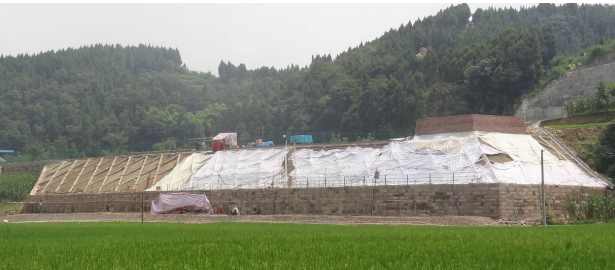
图1 某天然气井场滑坡全貌
