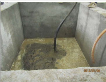
图5 振动棒振捣
