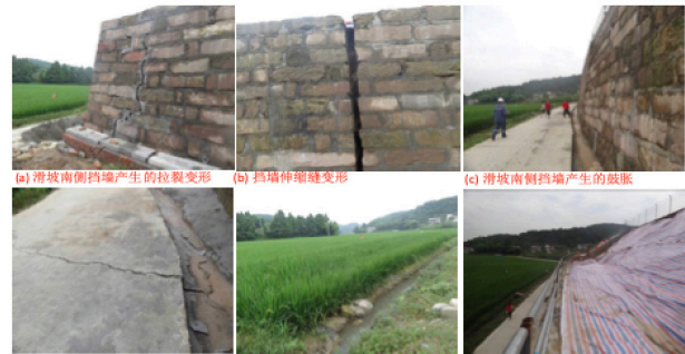
图3 滑坡前缘变形现象
