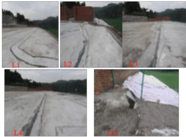
图2 滑坡产生的拉张下错裂缝（L1~L5）
