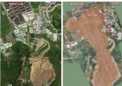
图5 光明红坳填土边坡滑坡（2015年12月20日）
